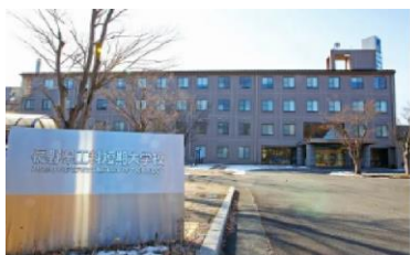
長野県工科短期大学校
