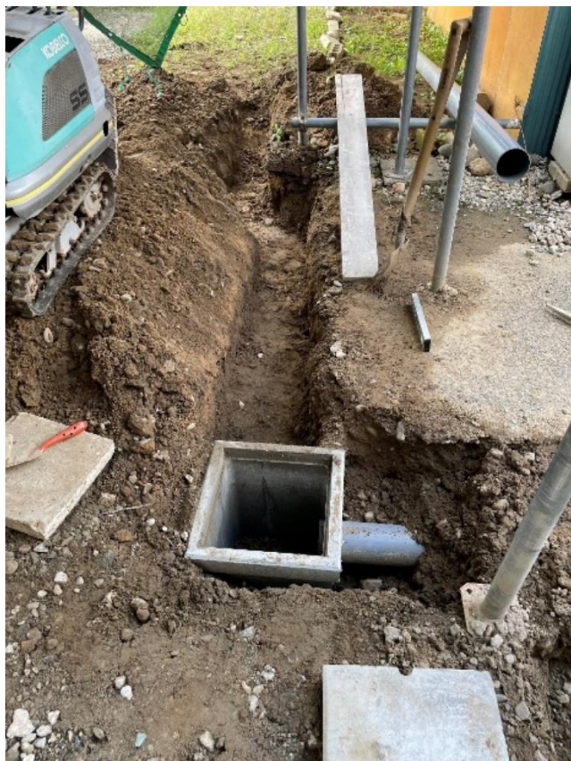
写真5 排水管設置①
