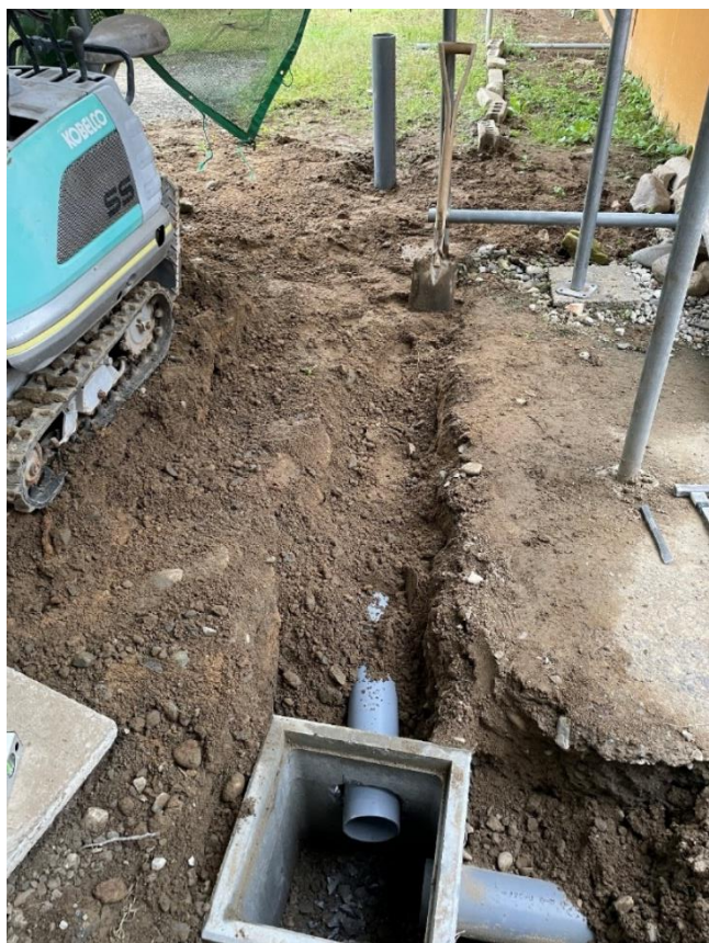
写真7 排水管設置③
