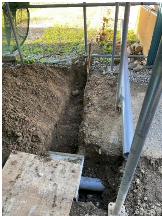
写真6 排水管設置②
