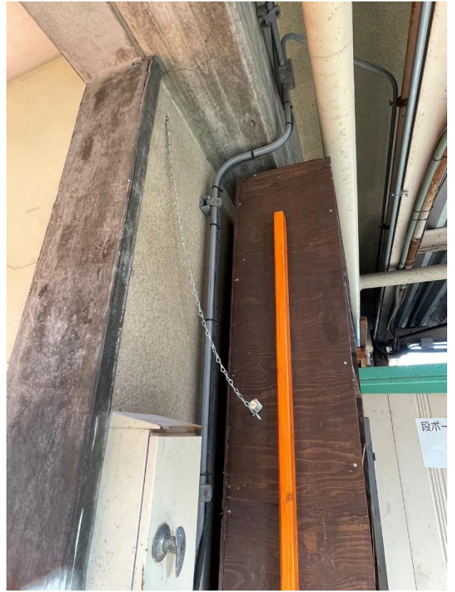
写真10 下駄箱設置 (転倒防止金物)
