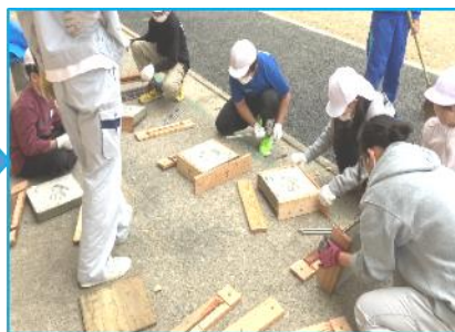
数日後、コンクリートが固まり、 型枠を分解し型枠から外した
