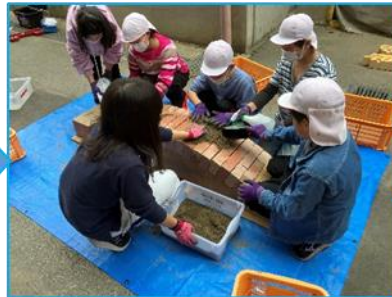
レンガのすき間に砂をすり込むように詰めます
