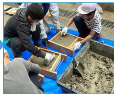
型枠に移し、コテで 締め固めと平らに仕上げ
