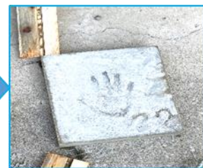
型枠に移し、コテで 締め固めと平らに仕上げ
